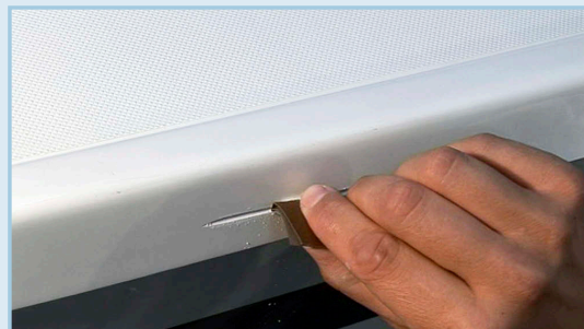
Schleifen der Schadensstelle
